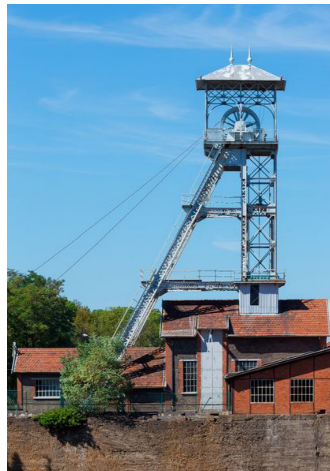
Vues du chevalement métallique
